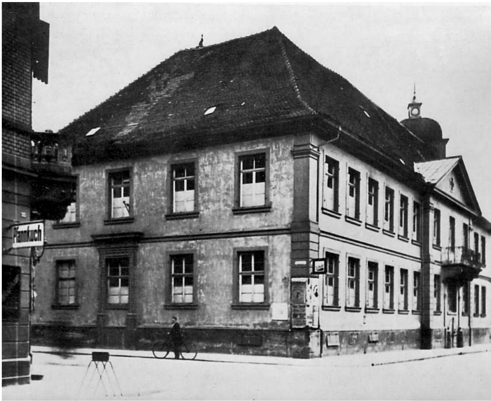
Schulhaus „Alte Dechanei“
