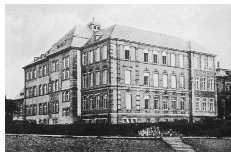
1892 errichtete Städtische Höhere Bürgerschule für Knaben mit Erweiterungsbau von 1914. Rechts daneben die Reserve (ehem. Wasserreservoir, erbaut unter Fürstbischof Hutten)
